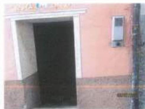
ingresso diretto da esterno
